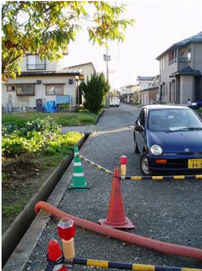
写真7 図6よりもたらされた下水。 右手にあるマンホール(写真にない)に 排出される。
