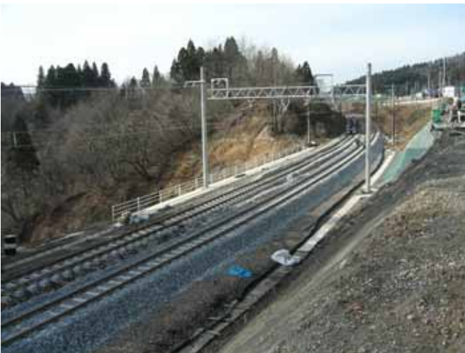
12月19日時点での復旧状況
