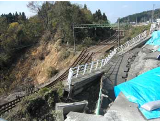
11月7日時点での被災状況
