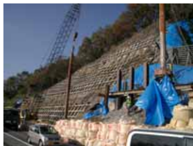
写真 2 のり面の補強工事の様子
