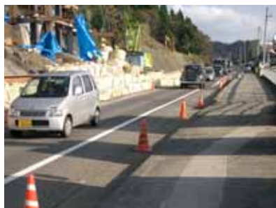
写真 1 片側相互通行の状況
