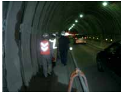
写真 2 開通した和南津トンネル
