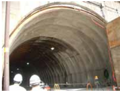
写真 1 崩落部分の補強状況
