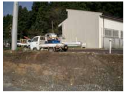
写真 3 取り壊された民間施設
