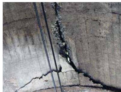
写真 5 坑口クラウン部
