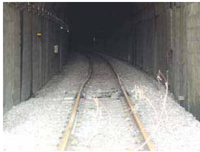
写真 2 レールの状況
