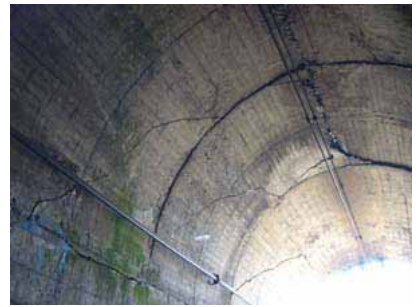
写真 3 坑口付近の状況
