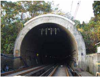
写真1 トンネル坑口
