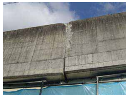
写真3 上部工の状況
