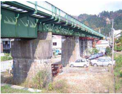
写真 1 高架橋部全景
