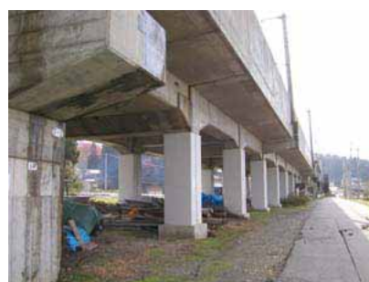
写真4 耐震補強された橋脚
