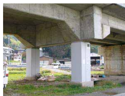
写真5 鋼板による補強状況
