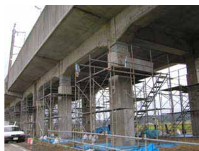
写真2 柱機能が維持された橋脚
