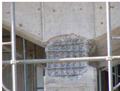
写真4 損傷箇所はつり状況
