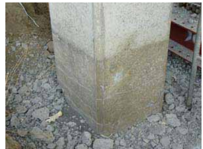
写真3 地中部の塑性ヒンジ
