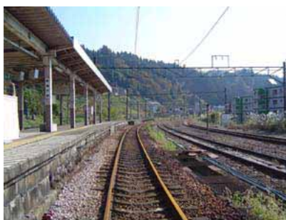
写真 2 地上部の状況
