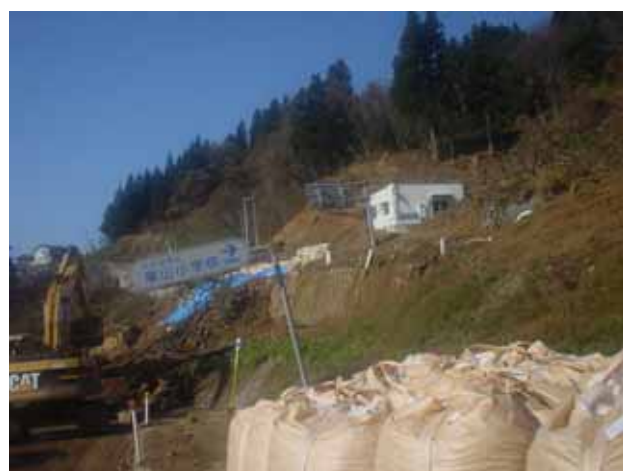
写真2 中山の深層崩壊（近景）
