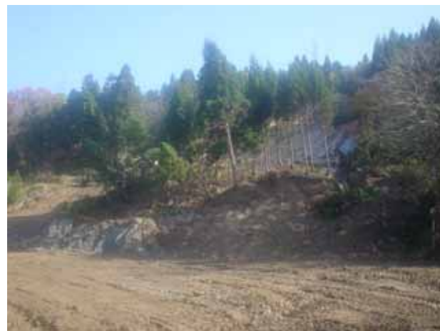
写真2 別の岩盤すべり面
