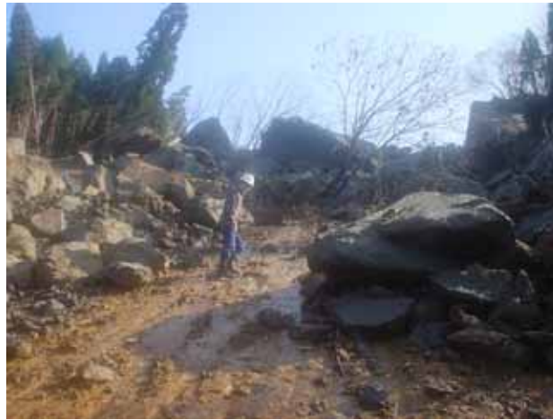
写真1 岩盤すべり面（すべり面が酸化している）
