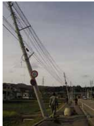
写真4 電柱の傾斜
