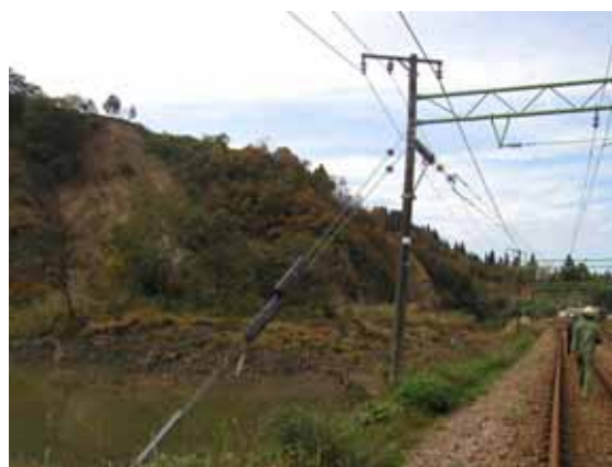
写真 4 北側の崩壊箇所
