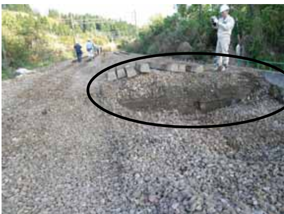
写真5 ボックスカルバート背面の沈下
