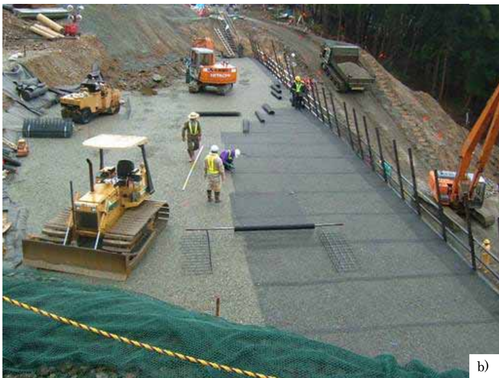
写真 10 220k900m 付近での上越線復旧状況(12 月 5 日現在) : a) ジオテキスタイル補強土擁壁の概要、 b) 高分子補強材の敷設状況
