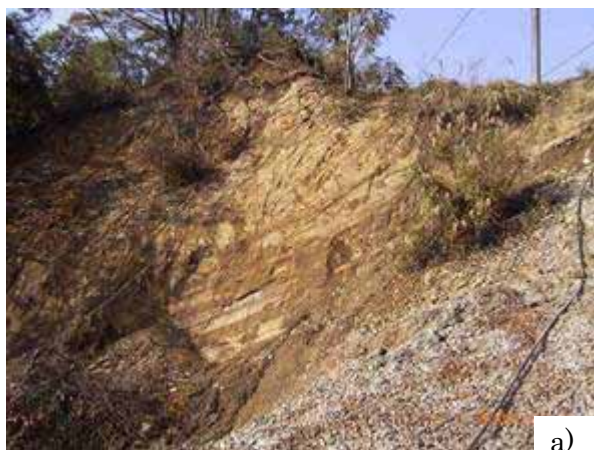
写真5 盛土材料(220km900m 付近：円礫が混じっているが、多くは細粒分質砂であり、締め固め度は高くないように感じられた)
