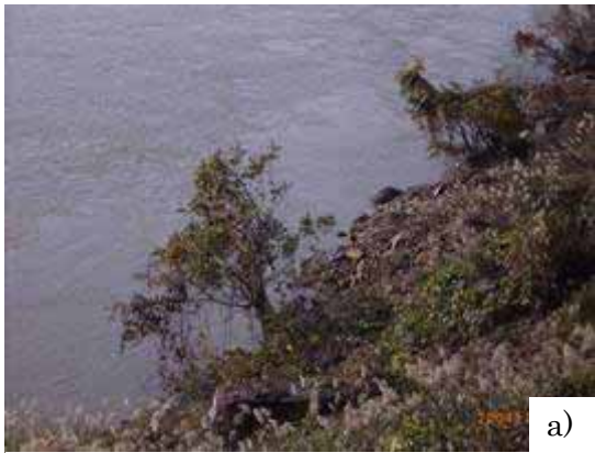
写真 8 220km500m 付近の被害状況(その 3) : 写真左手は信濃川。220lm900m 地点での崩壊盛土と同様に、当該盛土も信濃川右岸の沢地形の斜面上に建設されたものであったことが分かる。
