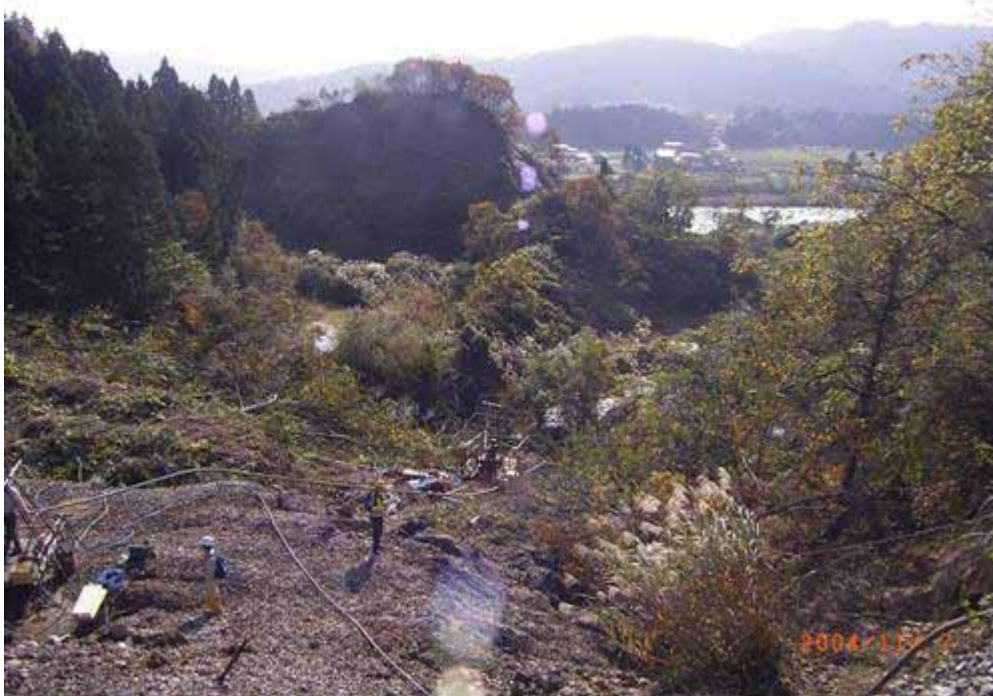
写真4 盛土崩壊地の地形(220km900m 付近：写真奥に信濃川が見える。崩壊盛土した盛土は信濃川右岸の沢地形の斜面上に建設されたものであったことが分かる)
