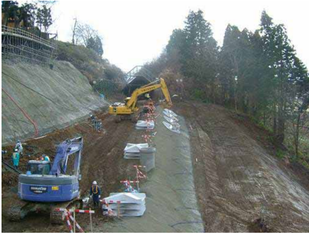
写真 11 220km500m 付近での上越線復旧状況(12月5日現在)：斜面上にジオテキスタイル補強土擁壁が構築される。12月5日時点では、基礎(セメント改良+アースアンカー)打設が終了。基礎の上にジオテキスタイル補強土擁壁が構築される。
