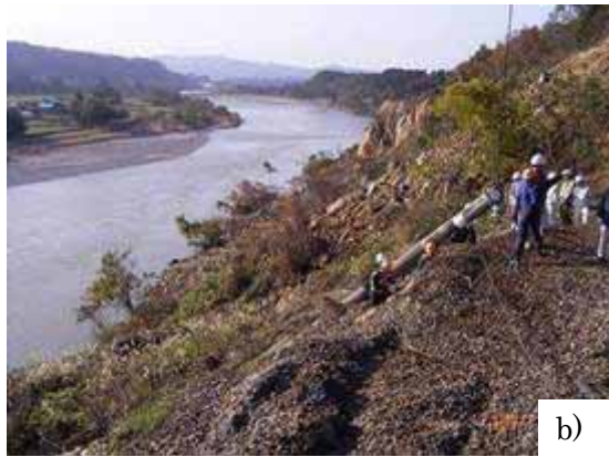
写真 8 220km500m 付近の被害状況(その 3) : 写真左手は信濃川。220lm900m 地点での崩壊盛土と同様に、当該盛土も信濃川右岸の沢地形の斜面上に建設されたものであったことが分かる。
