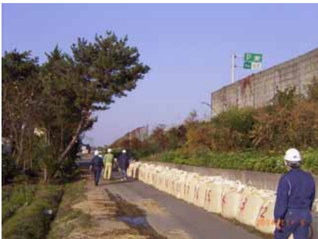
写真 3 腰土留めの傾斜（写真 1 とは反対側）
