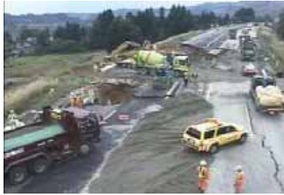
写真2 復旧状況①
