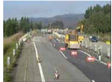
写真3 復旧状況②
