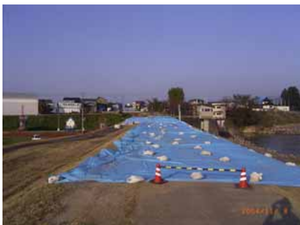
写真 1 応急復旧済みの土堤
