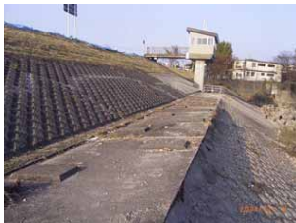
写真 2 補修済みのコンクリート護岸
