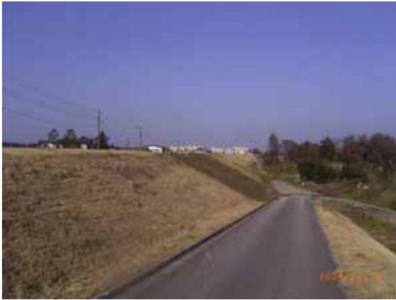
写真 1 土堤（堤外地側）
