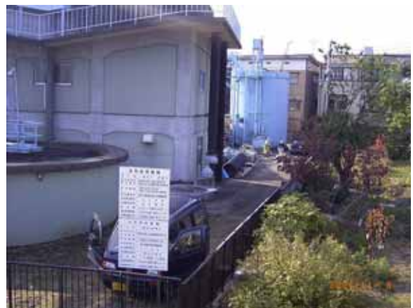
写真 4 浄水場における復旧工事
