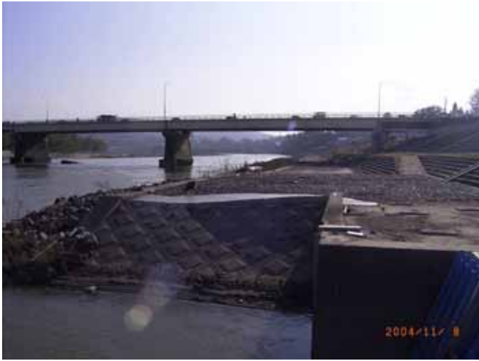
写真2 平張りのコンクリート沈下の復旧状況
