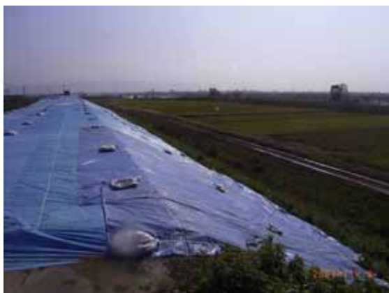
写真3 応急復旧完了後の状況（2004年11月8日）
