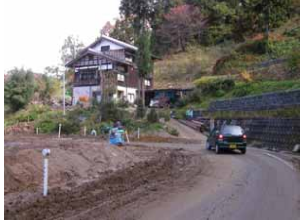
写真6 南側崩壊箇所の背後の状況
