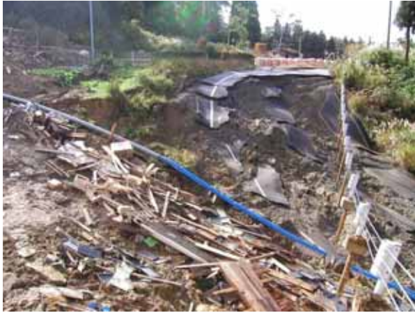
写真5 南側の崩壊箇所
