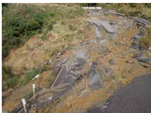
写真 1 北側の崩壊箇所（北方向を望む）
