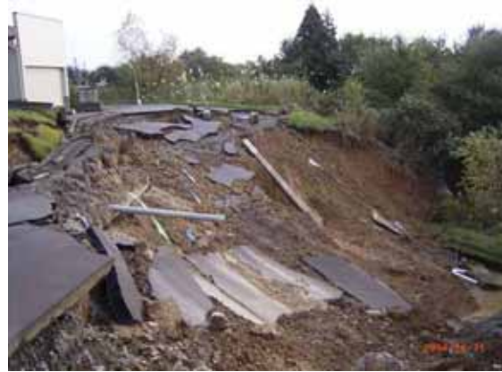
写真2 高町4丁目の被災箇所 (その1)
