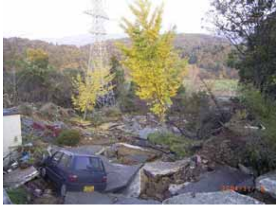
写真8 高町1丁目の被災箇所下部の送 電鉄塔
