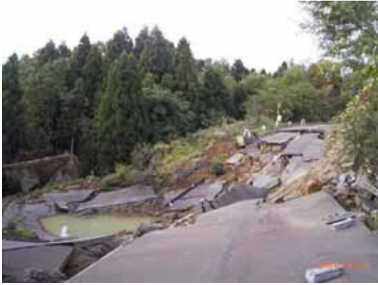
写真1 高町3丁目の被災箇所
