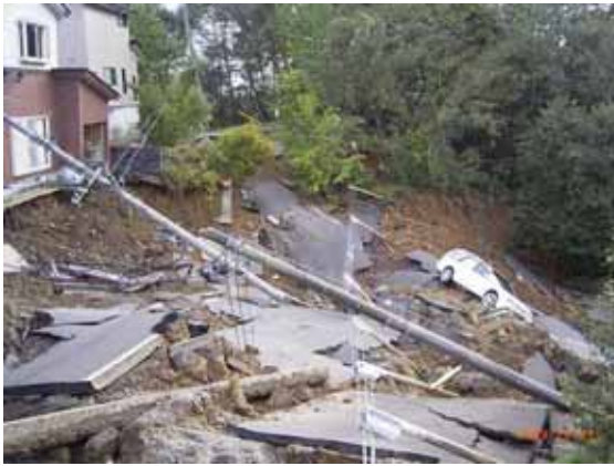
写真3 高町4丁目の被災箇所 (その2)
