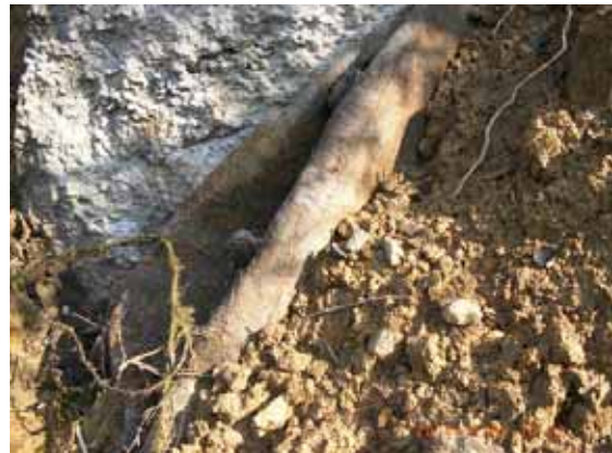
写真6 擁壁背面の排水材
