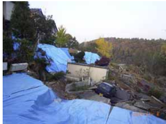
写真4 高町1丁目の被災箇所
