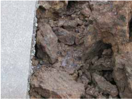
写真7 背面地盤に見られた湧水 or 漏水 電鉄塔
