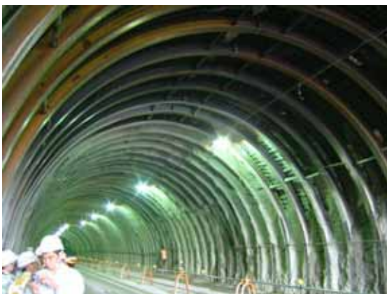
写真3 応急復旧後の状態(崩落付近)
