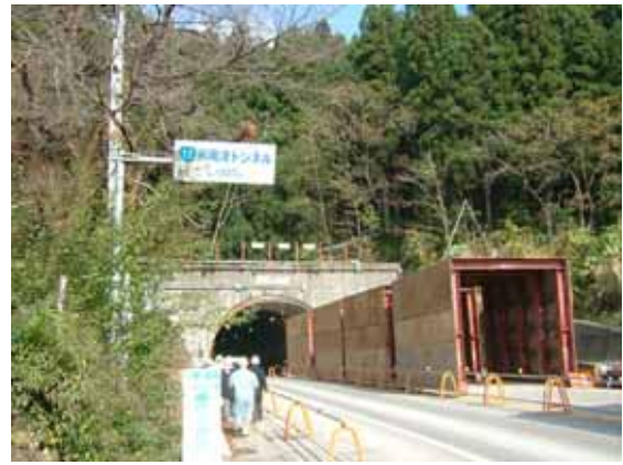
写真2 長岡側坑口(応急復旧の支保工設置が設置されている)
