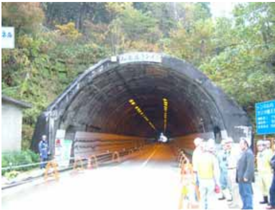
写真1 トンネル概要(東京側坑口：無被害)
