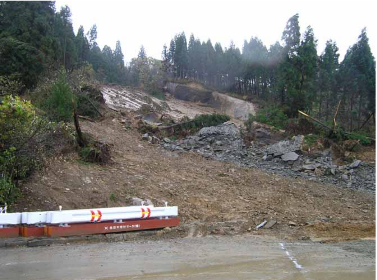
写真 1 すべり面の状況と隣接する未崩壊斜面
