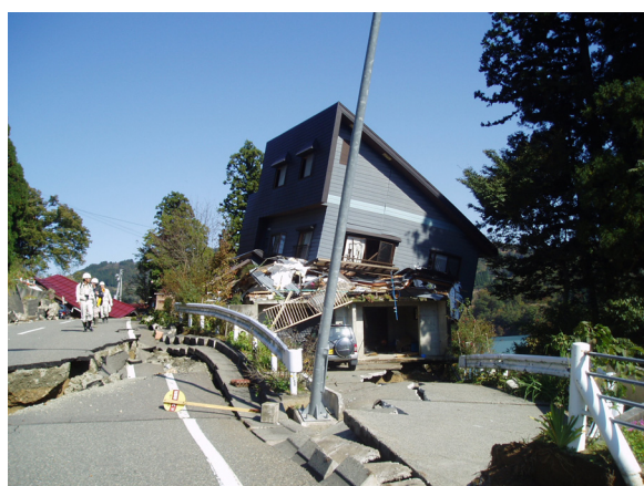
写真-11 被災した道路と家屋（山古志村）
