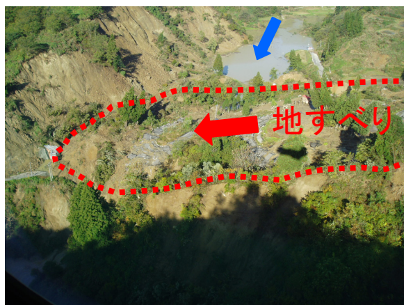
写真-1 竹野地区の河道埋塞状況（芋川流域）
