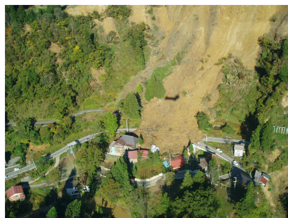
写真-10 山腹崩壊で寸断された道路（山古志村）
