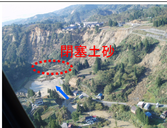
写真-5 樽木地区の崩壊と河道閉塞状況（芋川流域）
