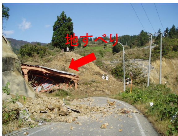
写真-4 竹野地区地すべりによる河道閉下流右岸状況（芋川流域）
