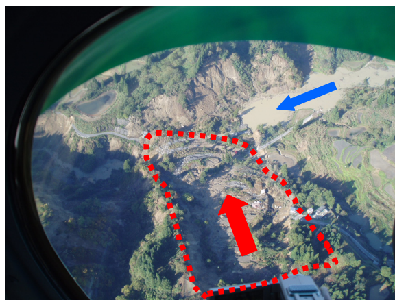
写真-2 寺野地区地すべりと河道埋塞状況（芋川流域）
