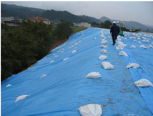
写真-3 信濃川 29.2km 長岡市三俣野町 (法面崩壊箇所の緊急復旧後の状況。崩壊した土砂を除去し新たに盛土した。さらに、防水のため、シート張を行った。)
