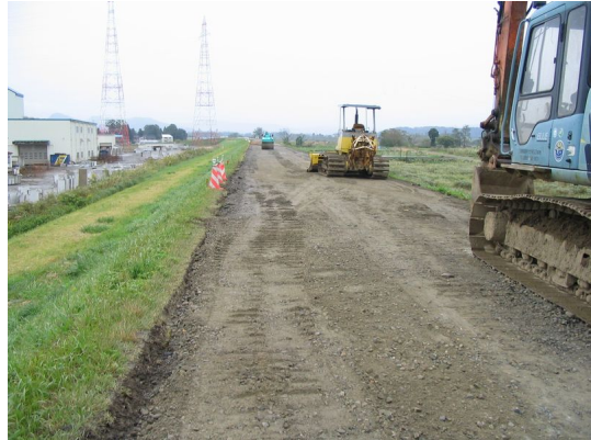
写真-2 信濃川右岸 26.5km 越路町釜ヶ島 (復旧作業状況。舗装を取り除き、土砂によって亀裂を充填・転圧している。)
