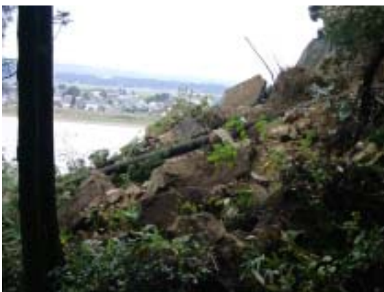
写真 - 5 崩落岩塊の状況(中腹部) (岩塊の径は1～3m程度)
