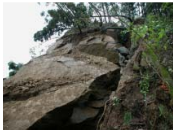
写真 - 6 崩落岩塊の状況(最上部) (岩塊の最大径は推定で約10m程度)
