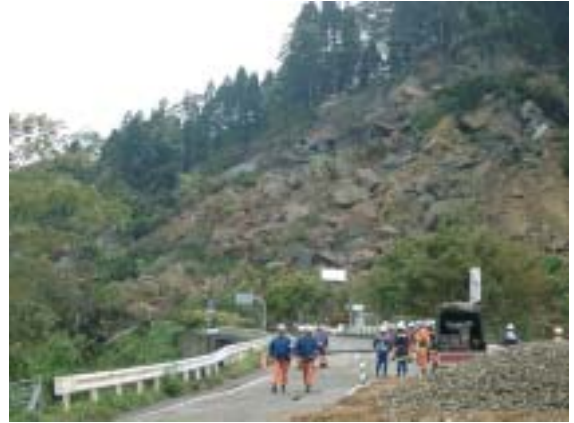
写真 - 2 崩落個所近景 (斜面部の状況)
