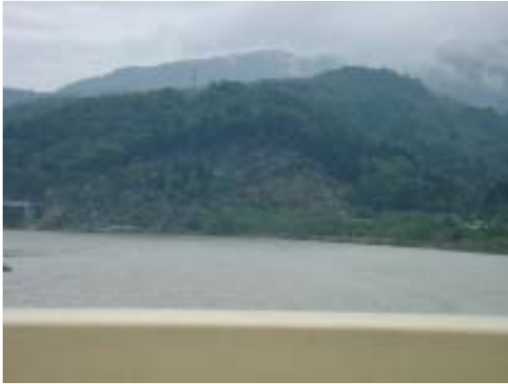
写真 - 1 岩盤崩落個所全景
