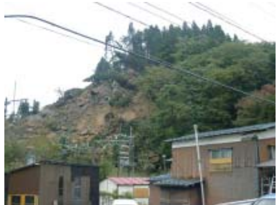
写真 - 4 JR側から見た側面の状況
