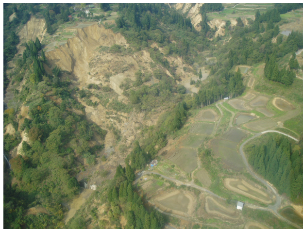
写真-8 大規模な地すべり性崩壊 (川口町、芋川流域)
