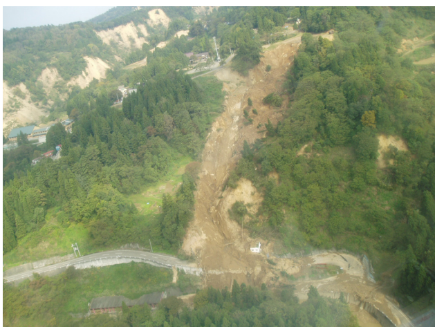
写真-9 斜面崩壊と山腹崩壊状況 (小千谷市南荷頃、朝日川流域)
