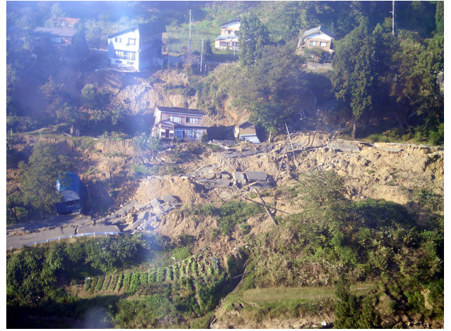
写真-2 斜面崩壊による人家被害 (山古志村役場付近)
