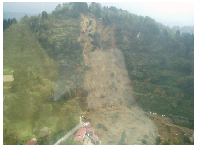
写真-4 羽黒トンネル付近の大規模な山腹崩壊 (山古志村竹沢地区)
