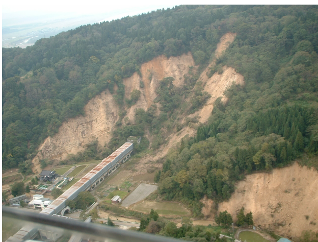
写真-12 上越新幹線妙見トンネル南坑口付近の崩壊 (上方が長岡方面、小千谷市浦柄地区)
