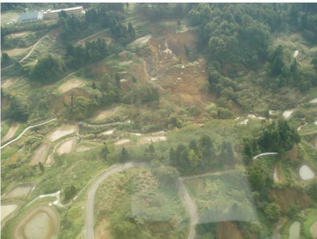
写真-3 小学校付近の地すべり性崩壊 (山古志村大内地区)
