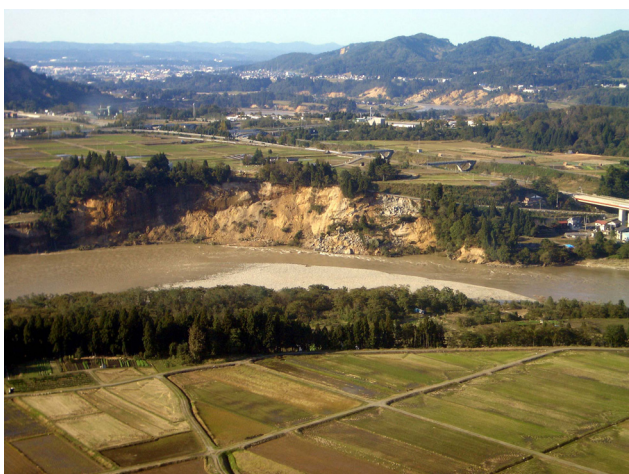
写真-11 信濃川の河岸崩壊状況 (川口町)
