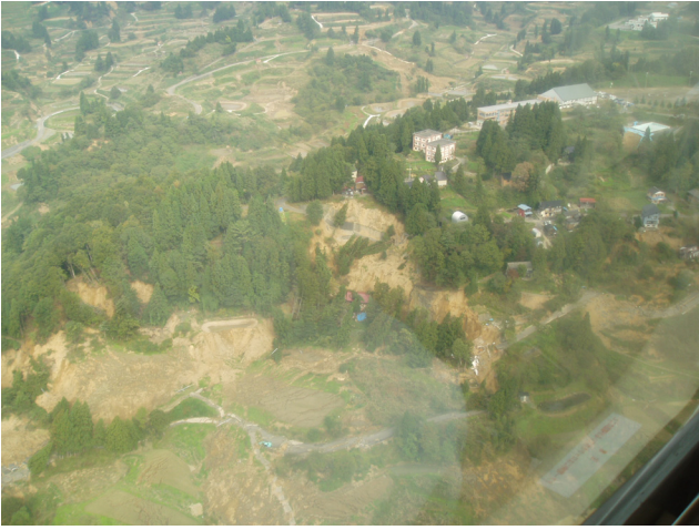
写真-1 山古志村中心部の斜面崩壊状況
