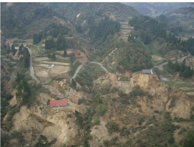
写真-5 大規模な地すべりと寸断された道路 (山古志村寺野地区)
