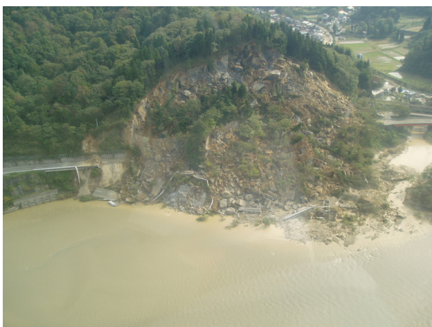
写真-10 信濃川と朝日川の合流点付近の岩盤崩壊 (小千谷市と長岡市の境界)
