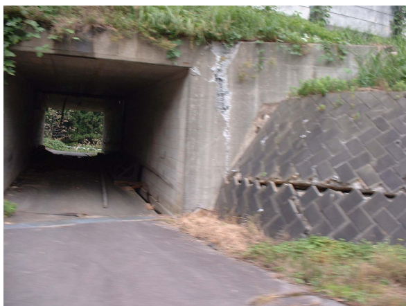
写真-5 関越自動車道を横断するボックスカルバートの被害
