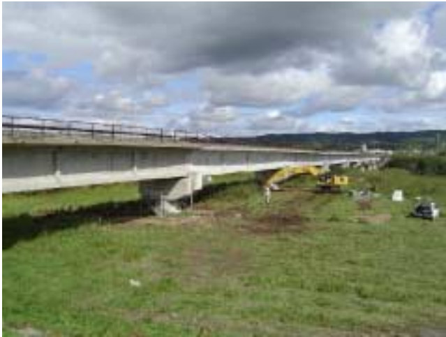
写真 - 1 利別川橋梁全景
