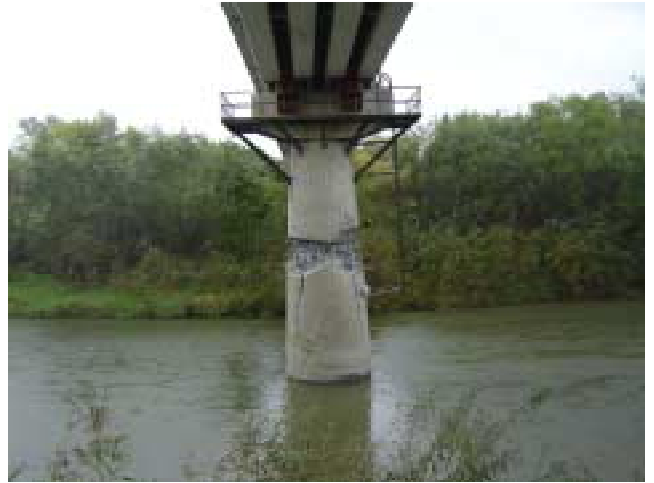
写真 - 2 浦幌川橋梁全景
