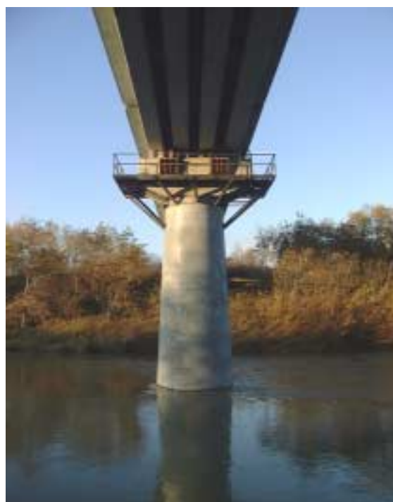
写真-4 浦幌川復旧完了
