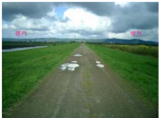
写真 - 6 十勝川右岸統内築堤
