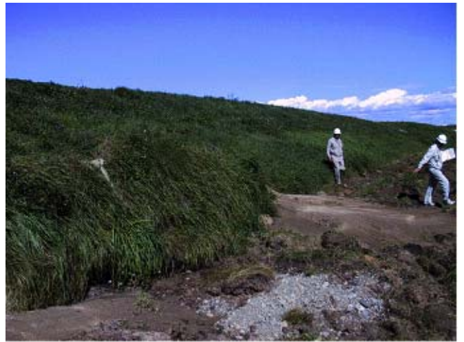
写真 - 5 牛首別川右岸築堤
