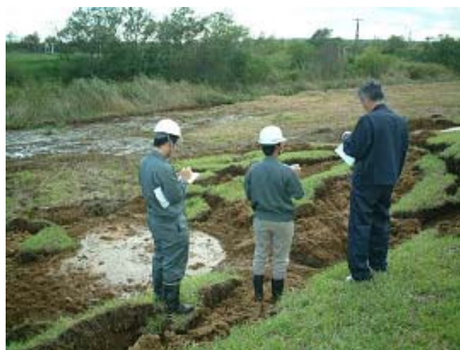
写真-2 十勝川右岸大津築堤 (提供:北海道開発局)
