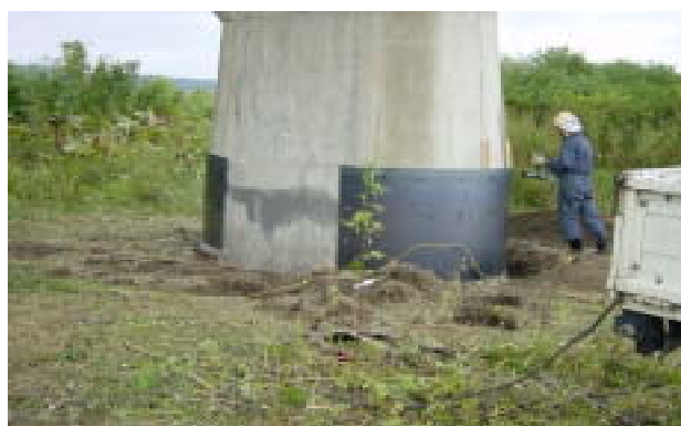
写真6 千代田大橋橋脚の鋼板接着補強
