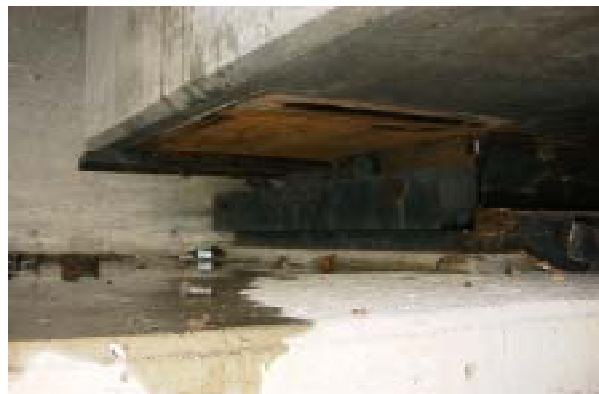
写真1 浦幌側橋台上で上流方向へ桁が移動(67cm、十勝河口橋)
