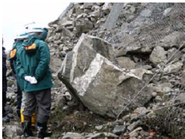
写真10 ほしば覆道上部の落石(大きさ2m)
