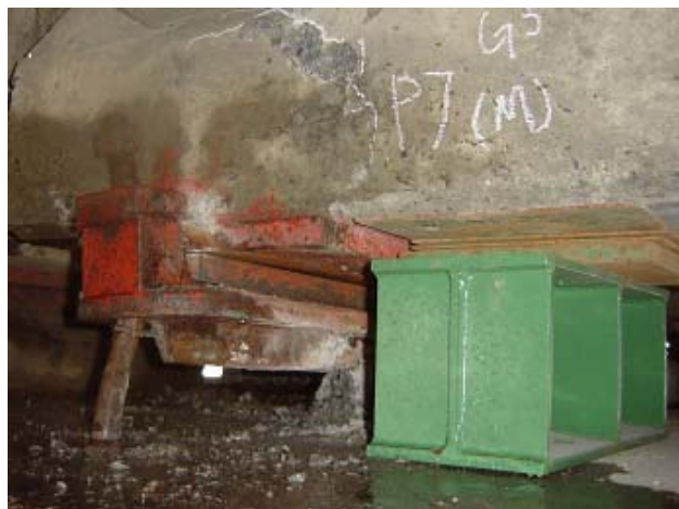
写真8 歴舟橋 支承部の仮受け
