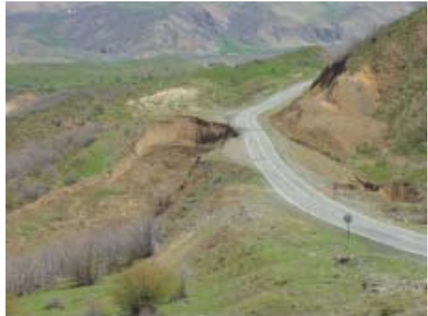
写真-1 ハイウェイにおける斜面崩壊
