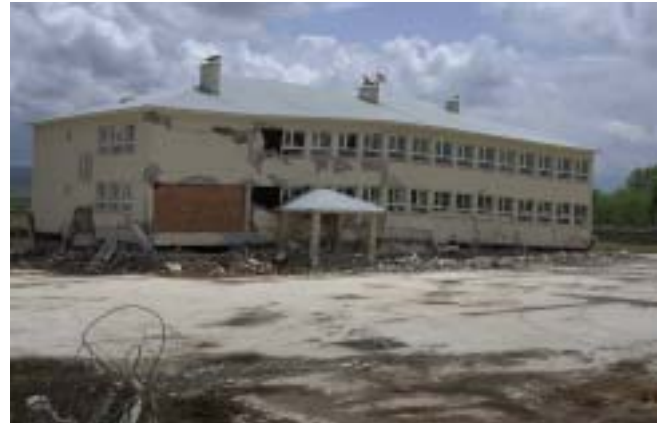
写真-5 Eltiksuu 小学校の校舎の倒壊
