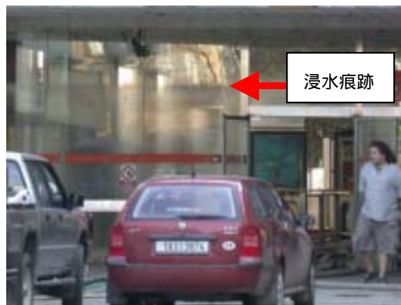
写真-1 地下鉄入り口の浸水痕跡(プラハ)
