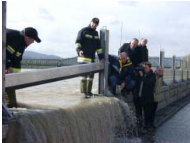
写真-3 可搬式の特種堤防、ドナウ川クレムスでの例 (パッサウ市役所提供)
