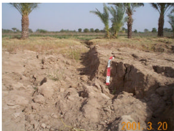
Photo 3 南側が 50cm 程度隆起しているリッジ
