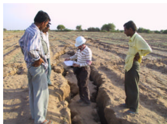
Photo 4 Chobari 村近くの畑の中の地割れ
