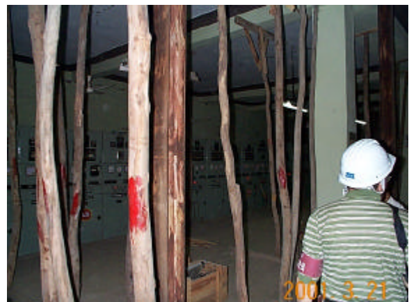
Photo 25 コントロール室の天井を支える丸太
