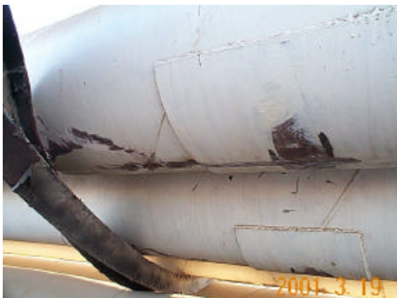
Photo 23 下面に残された震動の跡
