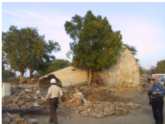
Photo 28 Chobari の倒壊した給水塔
