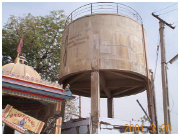
Photo 27 Anjar の給水塔
