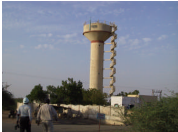
Photo 26 Maliya の給水塔
