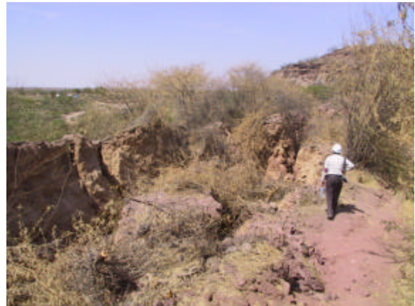
Photo 19 堤頂部の大被害
