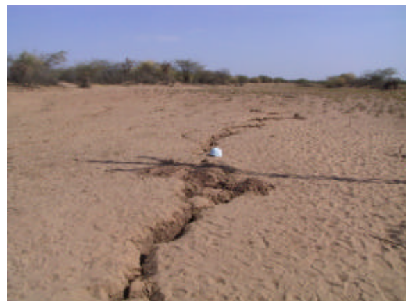
Photo 3 Manfera 村付近の荒野の中の地割れ
