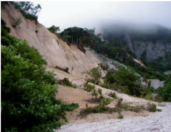
写真-4 神津沢ダム内の斜面崩壊
