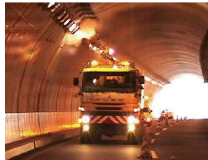
図-2 キャビテーション高速清掃 50km/h
