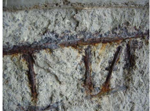
写真2 橋台部分の近接撮影 (写真1の丸印の部位)
