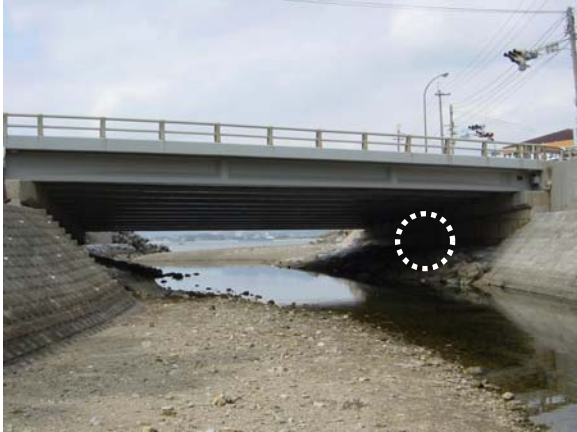
写真1 調査対象の橋梁
