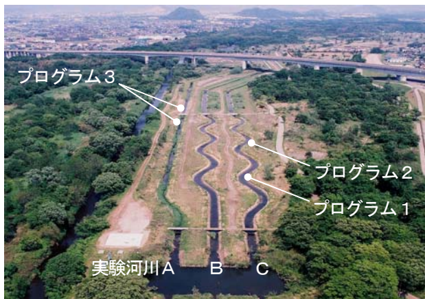
写真-1 実験河川の全景
