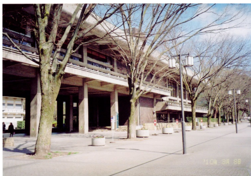
写真-3 京都会館。正面側を通行する人間には音楽ホールの高層部は見えない。又ファサードには2階、中2階に廻廊が設けられている。
