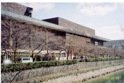
写真-4 同上。側面の疎水側に廻ると高層部が見える。
