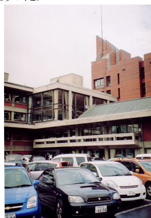
写真-8 弘前市庁舎。手前建物の連続窓と右手奥の増築部の奥窓表情の違い。
