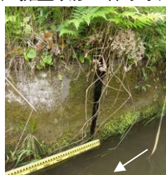
写真-9 護岸破損状況と施工前の水路状況。
