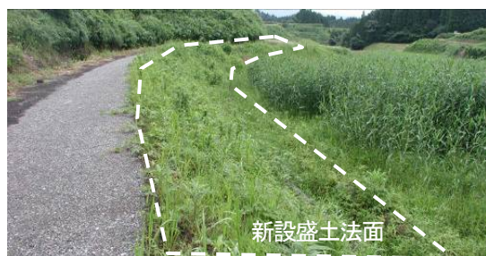
写真-5 埋土種子の発芽による植生繁茂状況(施工後約3ヶ月)。
