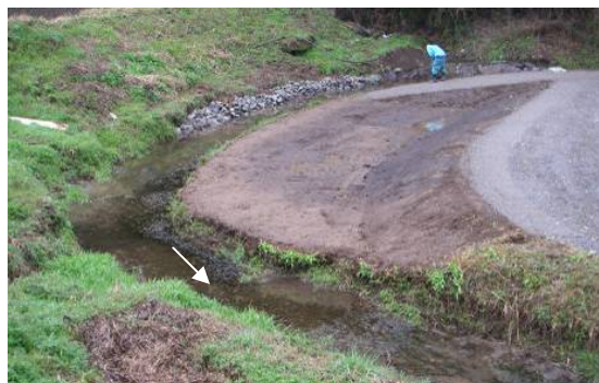
写真-12 水路拡幅箇所の施工直後の状況
