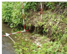
写真-7 侵食された水路岸と詰め石設置状況。
