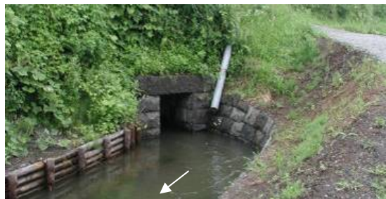
写真-19 坑口完成写真（工事後3ヶ月）。
