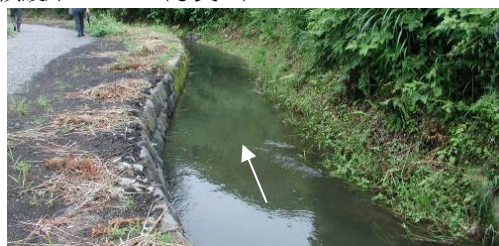
写真-6 石積護岸完成状況。対岸は非改変。
