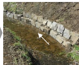
写真-7 侵食された水路岸と詰め石設置状況。
