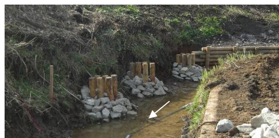
写真-8 杭出し設置状況。
