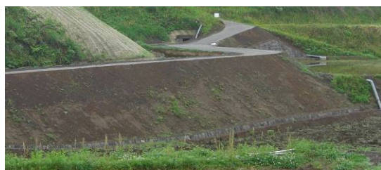
写真-4 管理用通路盛土(施工後数週間)。
