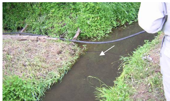
写真-13 上井手合流地点の工事前の状況。
