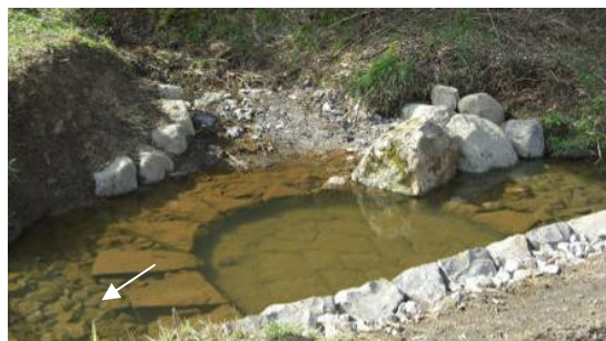
写真-14 上井手合流地点の改修状況。
