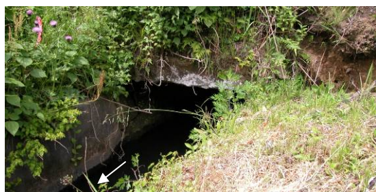
写真-18 モデルとした6号水路上流坑口（改修前）。
