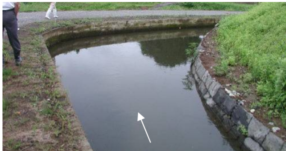
写真-10 改修後の状況
