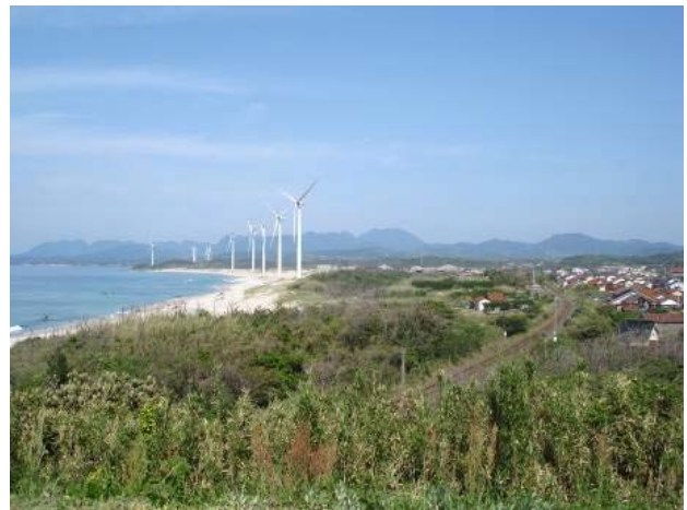
図-8 海岸線に林立する風力発電施設
