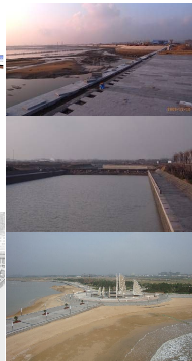
図-19 施工中の現地
