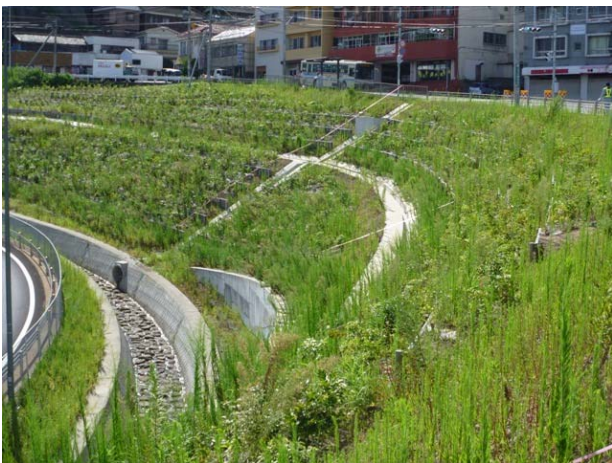
写真-12 2010年9月の佐世保中央インターの状況
