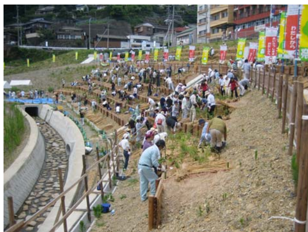
写真-6 佐世保中央インターの急斜面での植樹、敷きわら作業
