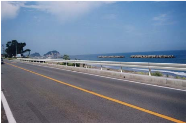
写真-1 沿岸部 ガードレール ホワイト
