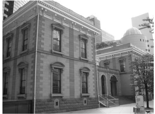
図-9 旧新橋停車場
